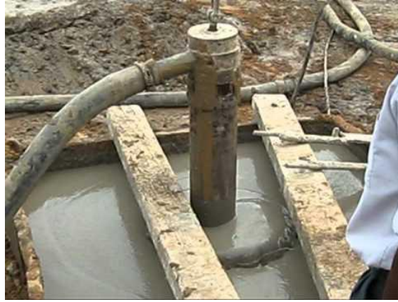
Fig. 2.51 Using Bentonite
