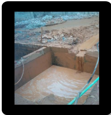
Fig. 2.7 Using bentonite (step 05)
